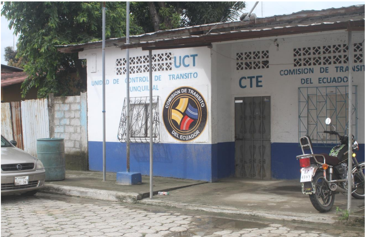
Visita técnica a las instalaciones de la Comisión de Tránsito del Ecuador.
